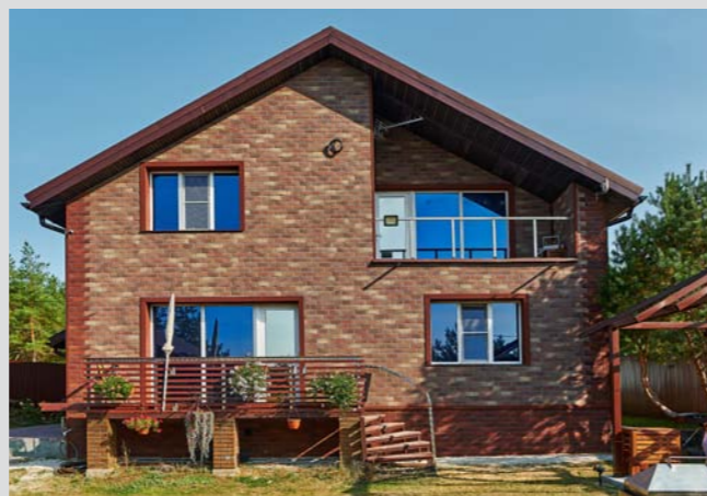
Объект «ПОСЛЕ». Коллекция КИРПИЧ, цвет Английский кирпич
